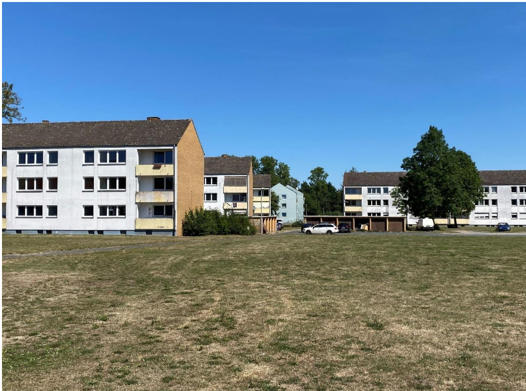
Abbildung 36: Leerstehende Wohngebäude im Sanierungsgebiet Weinberg
