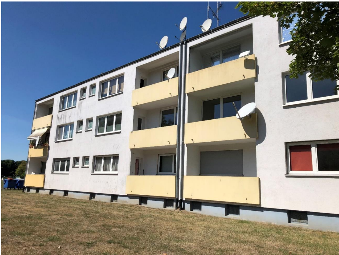
Abbildung 16: Wohngebäude im Sanierungsgebiet Weinberg
